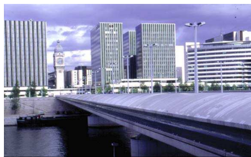
Un exemple d'une grande réalisation parisienne Le pont Charles de Gaulle
